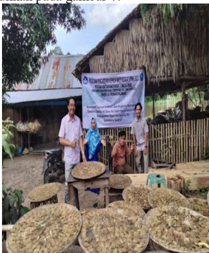
Gambar 6. Ruangan Produksi kerupuk ikan sarden tampak dari depan(sebelum di renovasi)
