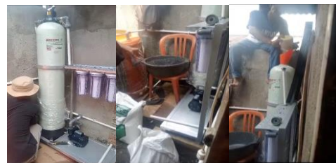
Gambar 6. Proses pemasangan alat pengolahan air
