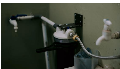
Gambar 7. Pemasangan filter air kapur di SD Negeri Kalidadap
