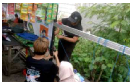
Gambar 22. Proses Pemasangan Tali Tambang Sempoa
