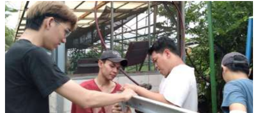
Gambar 18. Proses Pengeboran Pagar Pembatas Baja Ringan.
