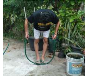
Gambar 38 Pelengkungan Besi dan Selang.
