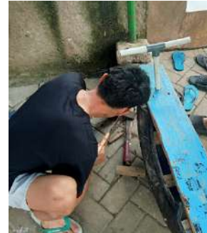
Gambar 30. Pemasangan Alas Duduk dan Pegangan Pipa
