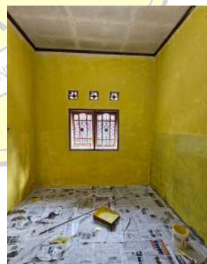
Gambar 2. Kondisi kamar dalam proses pengecatan dinding kamar.
