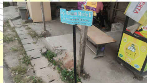
Gambar 4. Pengecekan Kondisi Rambu Eksisting.
