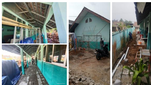
Gambar 8. Proses pekerjaan keramik, perkerasan, dan rangka plafon
