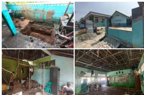
Gambar 7. Dokumentasi pekerjaan pembongkaran pagar, saluran utilitas-drainase, dan ruang guru
