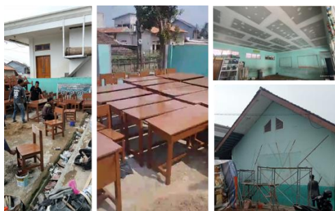
Gambar 9. Dokumentasi pekerjaan pengecatan furnitur dan dinding sekolah
