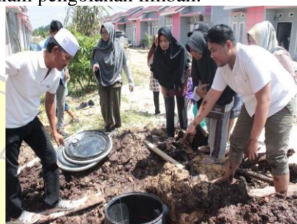
Gambar 2. Pemasangan tangki septik bio-porta di salah satu rumah warga
