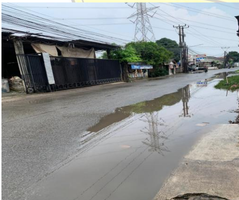
Gambar 2 Genangan akibat hujan
