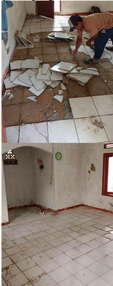
Gambar 1. Kondisi Prasarana Mushola Nurul Huda
