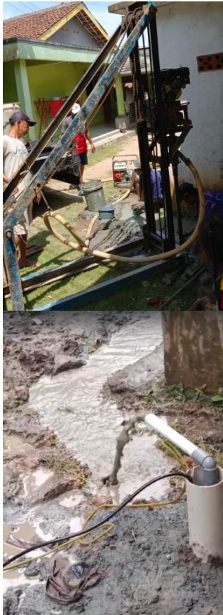
Gambar 4. Pekerjaan Pembuatan Sumur
