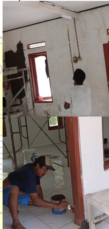
Gambar 5. Pekerjaan Perbaikan Mushola
