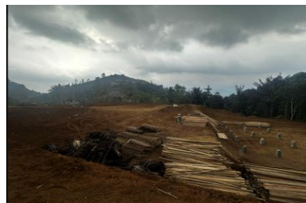
Gambar 4 Pembangunan Kampung Adat Baru (relokasi)
