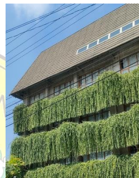
Gambar 10. Pembayangan Greenhost Boutique Hotel, Yogyakarta (Sumber: dokumentasi pribadi)
