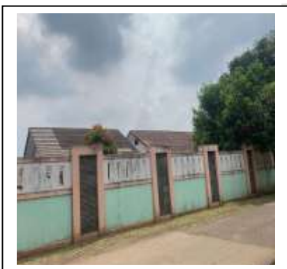
Gambar 6. Sebelum Pengecatan Pagar Sekolah
