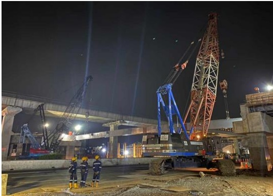
Gambar 1. Pekerjaan Lifting dan Erection Steel box Girder
