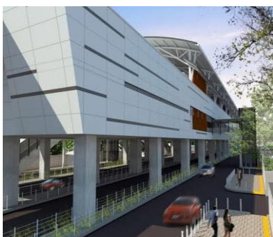
Gambar 10. Tampak Atap Stasiun MRT Lebak Bulus
