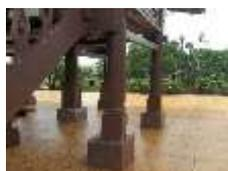
Gambar 13 ; Pondasi umpak rumah si Pitung
