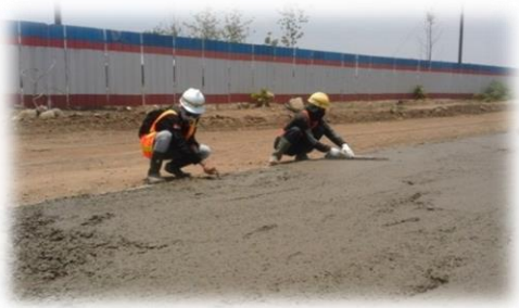
Gambar 11.b Ilustrasi Pekerjaan Lean Concrete Pekerjaan Jalan
