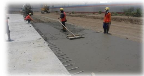
Gambar 10.a Ilustrasi Pekerjaan Lean Concrete Pekerjaan Jalan
