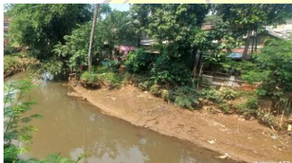
Gambar 4.1. Penyempitan dan Pendangkalan DAS Sunter RW 04 Kelurahan Cipinang Melayu.
