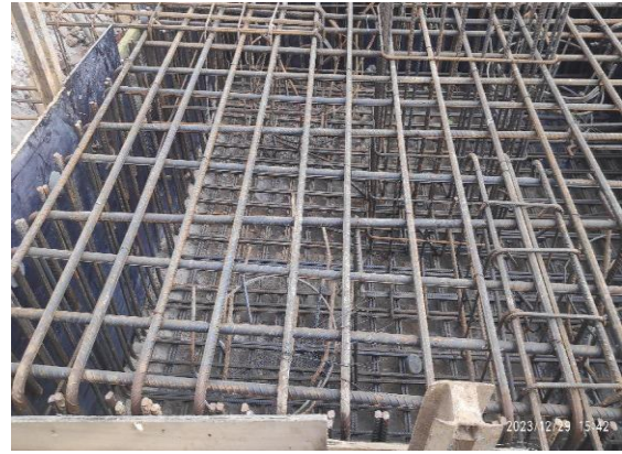
Gambar 8. Penjangkaran tulangan bor pile ke dalam pile cap (5)
