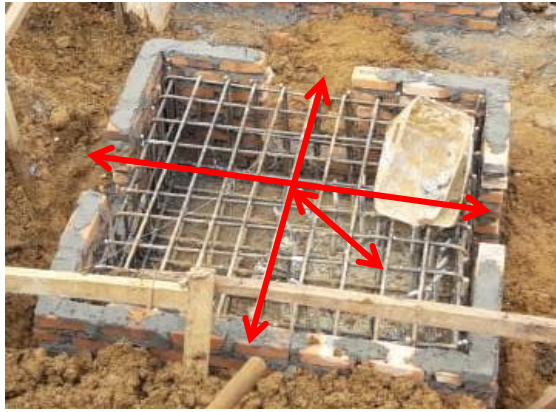
Gambar 6. Penjangkaran tulangan bor pile ke dalam pile cap (4)
