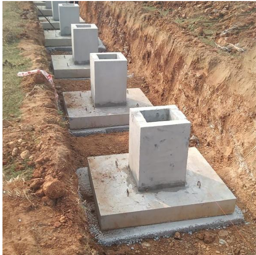
Gambar 6. Pondasi tapak pracetak dengan pedestal
