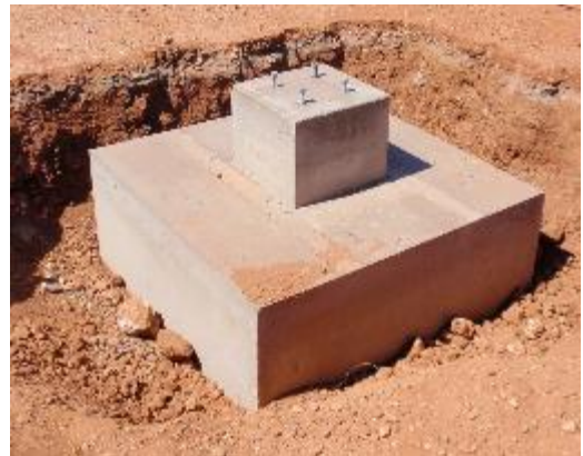
Gambar 4. Pondasi tapak pracetak
