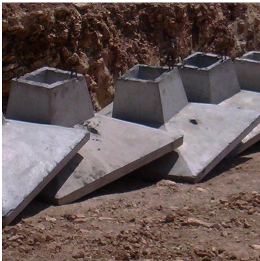
Gambar 7. Pondasi tapak pracetak dengan pedestal
