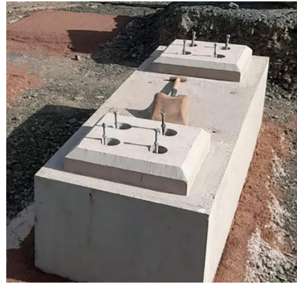
Gambar 3. Pondasi lajur pracetak
